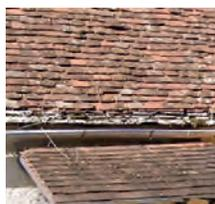
Toiture en tuiles plates avec des restes de lauze sur l'avant toit
